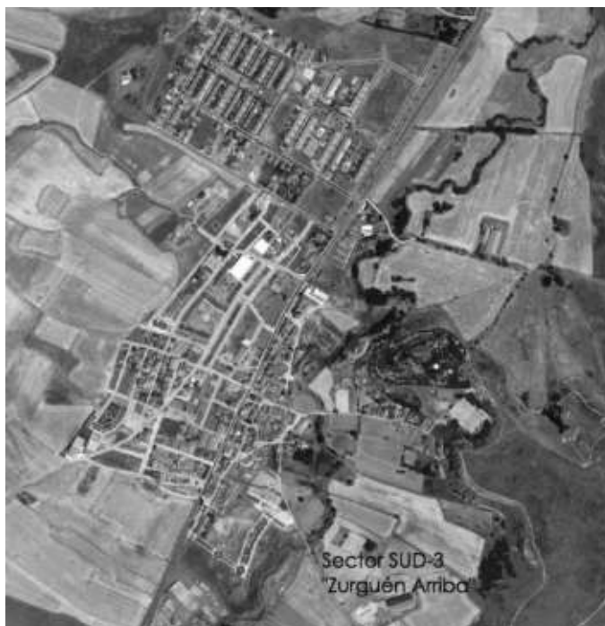
Ilustración 1. Localización del Sector SUD-3 "Zurguén Arriba" en el municipio de Aldeatejada
