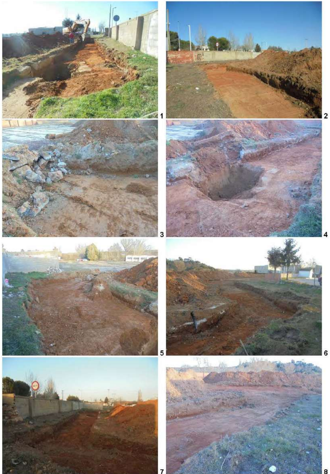
1-8.- Distintas vistas de la limpieza y desbroce efectuado en el entorno del sondeo 3, excavado en el año 2021.
