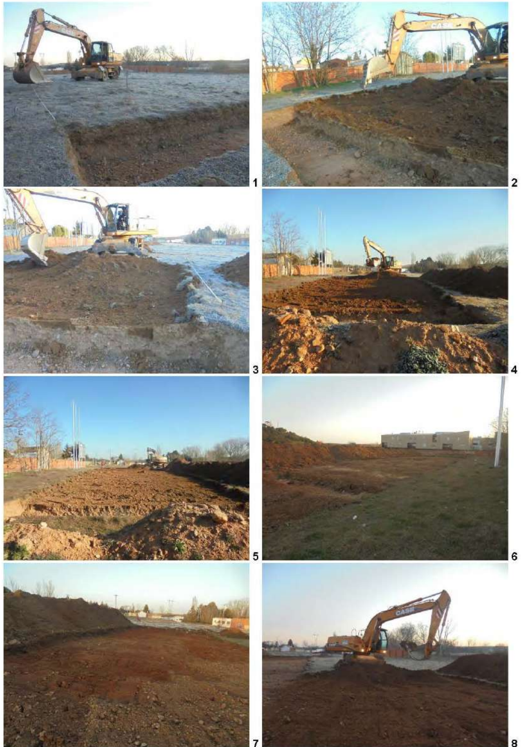
1-8.- Proceso de desbroce mecánico de las dos bandas situadas en la parte meridional del sector.
