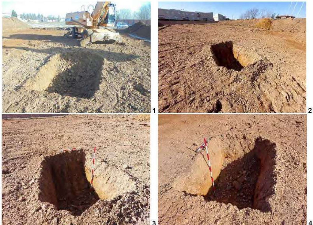
1-4.- Distintas vistas del sondeo A.
