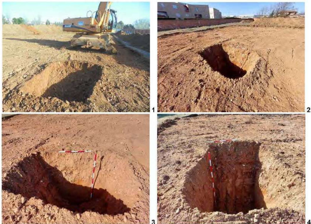
1-4.- Distintas vistas del sondeo C.
